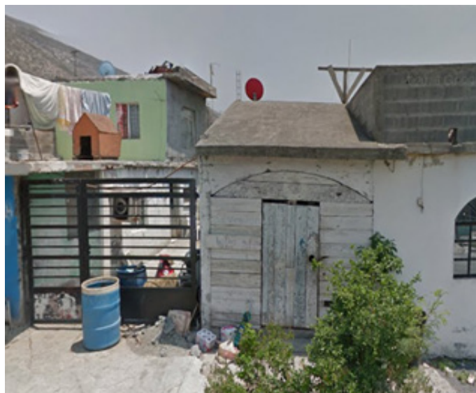
Imagen 02. Vivienda Unifamiliar, ubicada en colonia Gloria Mendiola, Monterrey, Nuevo León, México (Fuente: google maps).
